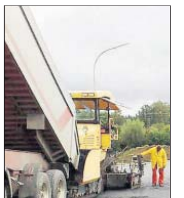
Fast fertig: Die neue Straße nach Martinlamitz
