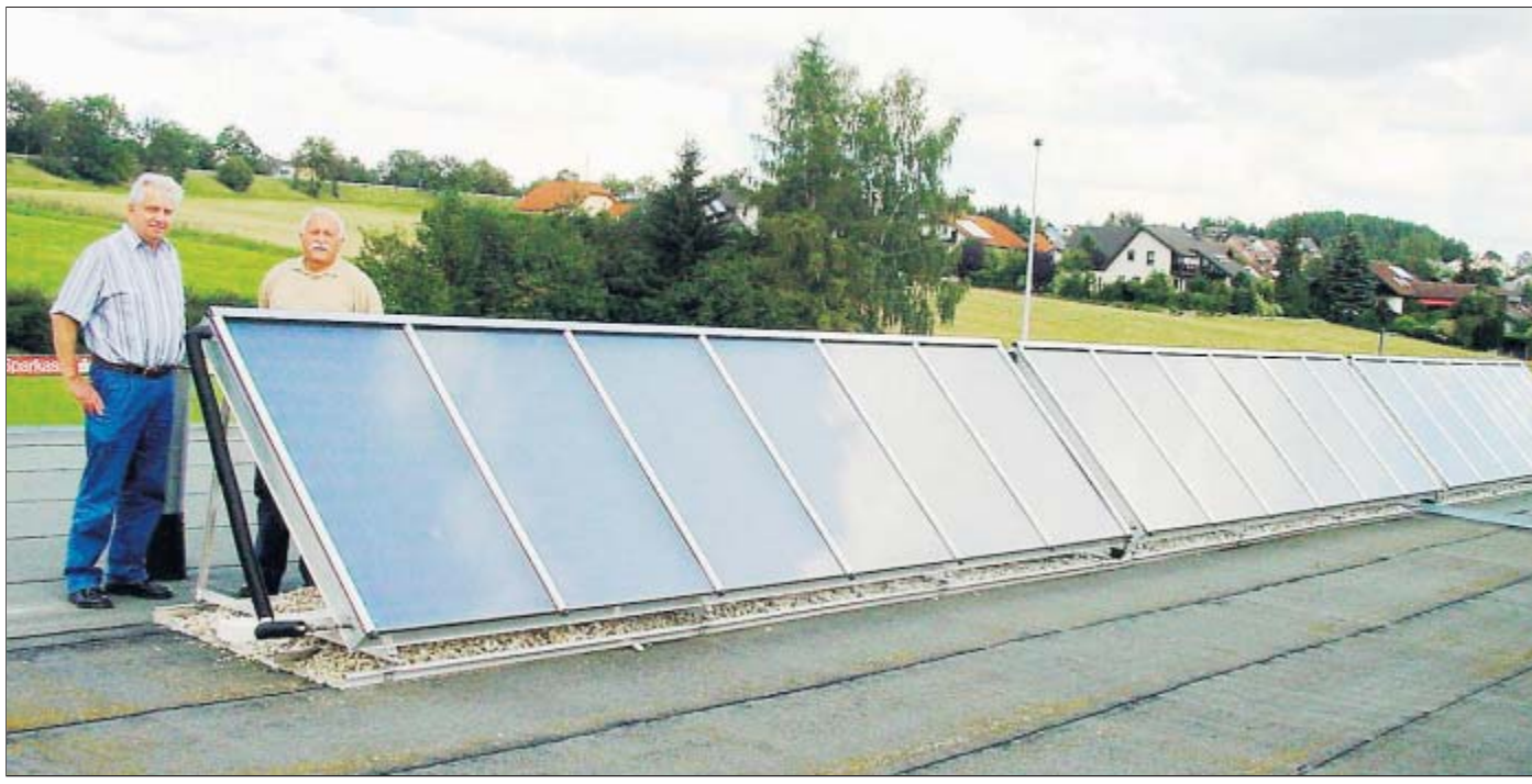
Besuch auf dem Dach des Döhlauer Sportheims. Andreas Gemeinhardt (l.) und Erich Groh inspizieren die Sonnenkollektoren. FOTO: A. K.
