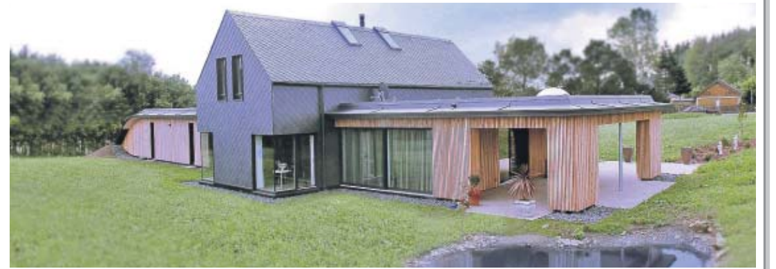
Das Frankenwaldhaus ist eine zeitgemäße Interpretation eines ortstypischen Gebäudes unter Verwendung regionaler Baustoffe. Foto: Christian Weber, Naila
