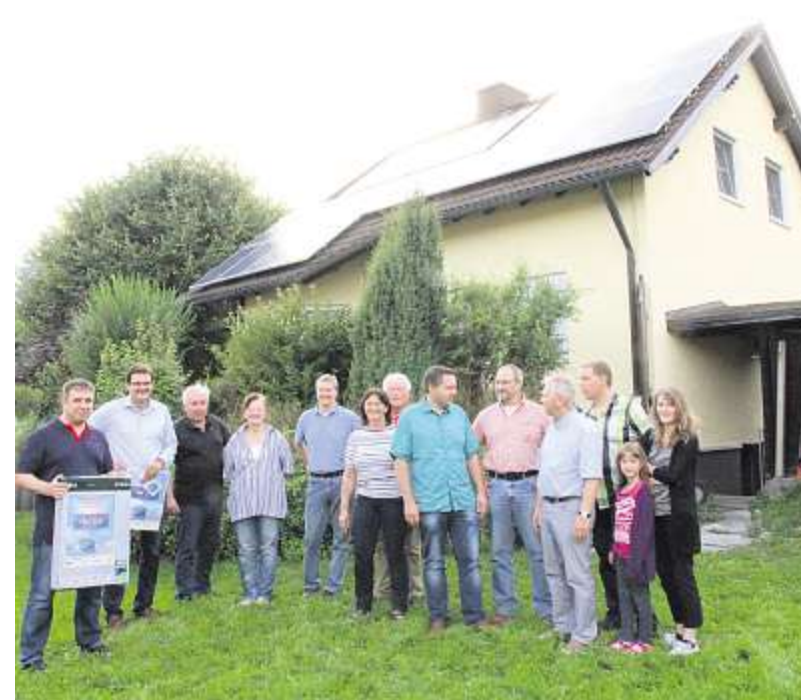
Die Interessenten der Solarspeicher-Aktion begutachten in Köditz die Lösung, mit der die Familie Kreil ihren Stromhaushalt effizient gestaltet. Auf dem Dach sorgen 24 PV-Module für Strom, der im Batteriespeicher im Keller auf den Abruf wartet.
