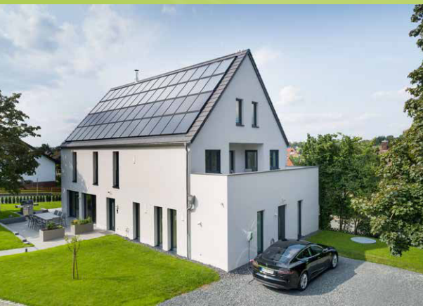
Ganz schön energiegeladen und gleichzeitig mehr als klimafreundlich: Das Sonnenhaus Plus + in Döhlau (Landkreis Hof) mit solarthermischer Beheizung und Smarthome-Feature gehört zu den Plusenergiehäusern.
