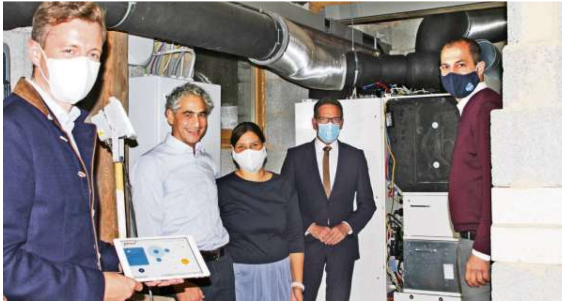
Zeyad Abul-Ella (rechts) erläuterte die Technik der ersten Wasserstoff-Speicheranlage. Landrat Oliver Bär, Robi und Kati Banerjee sowie Bürgermeister Michael Abraham (von links) freuen sich über das Engagement der Energie-Pioniere im Rehauer Ortsteil Wüstenbrunn. Foto: flo
