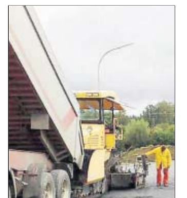
Fast fertig: Die neue Straße nach Martinlamitz
