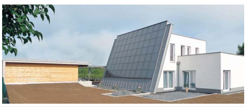
Das Sonnenenergiehaus in Oberkotzau. Foto: uf
